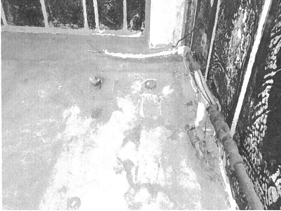
Kuva nro 30 vesi- ja viemäriliittymät on katkaistu
