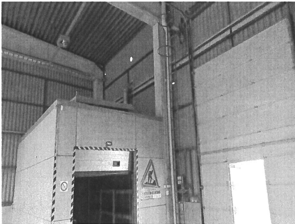
Kuva nro 28 ulko-oven läheisyydessä on levyrakenteinen tila
